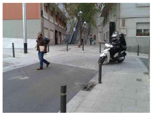
Manca de semàfor, pas de vianants i senyalització zona escolar, cruïlla perillosa (manca de visibilitat) Hortal / Batet
